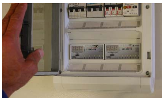
Montage i elskåp, allt åtkomligt från front.
